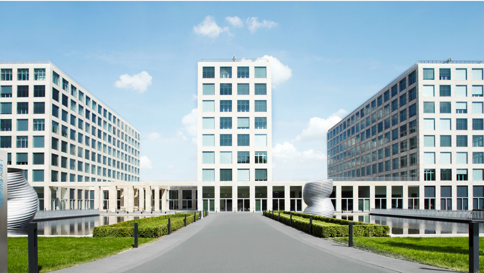
Die Hauptverwaltungen der Barmenia Versicherungen in Wuppertal
